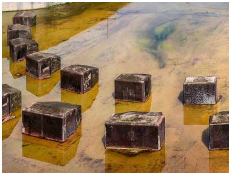
Disipadores de energía en el vertedero de Gatún. Estos son enormes bloques de concreto ubicados de manera estratégica para que la corriente de agua choque, se esparza y corra de forma controlada
