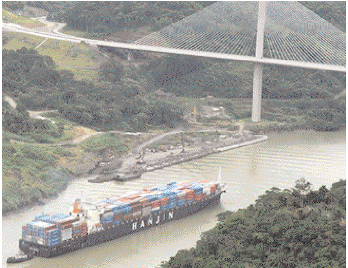
Estación de amarre en construcción en el Corte al norte de Pedro Miguel justo al pie del puente. En esta estación se puede amarrar un buque Panamax o dos de inferior tamaño. Este proyecto forma parte del plan para generar más capacidad para el Canal a corto plazo.
