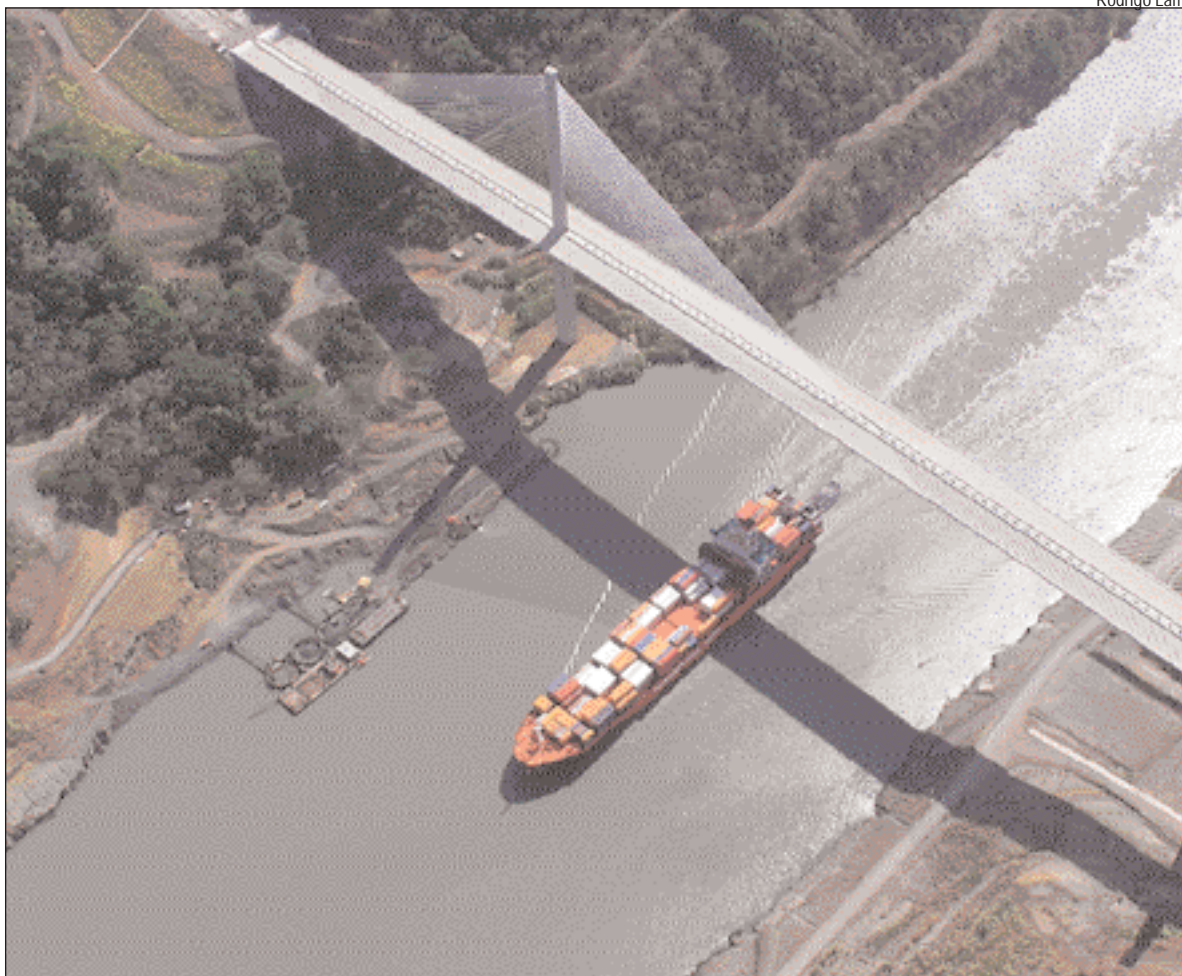
Vista del Puente Centenario y la construcción del nuevo atracadero de Corte Culebra.
