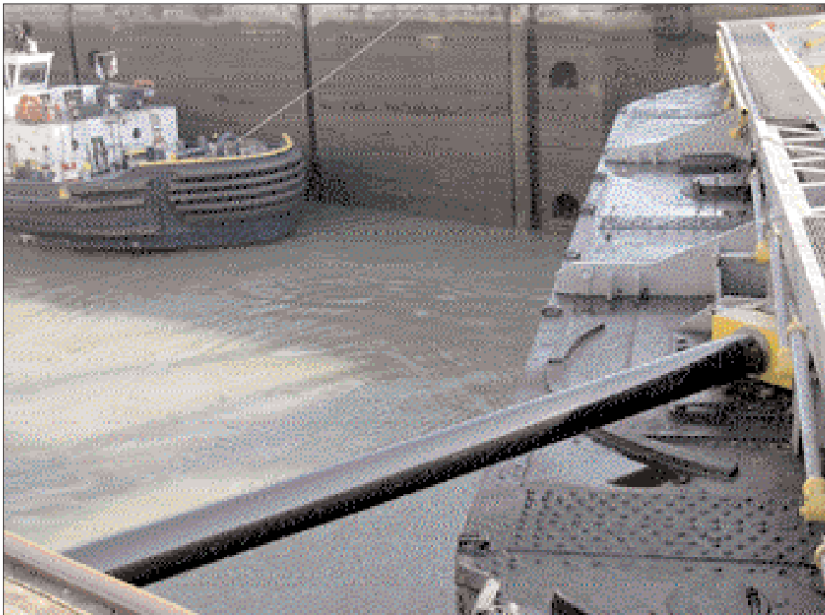
Un brazo muy poderoso: Los brazos hidráulicos, un importante elemento del plan de modernización llevado a cabo por la Autoridad del Canal, abren y cierran las compuertas para dejar pasar los barcos que transitan el Canal.
