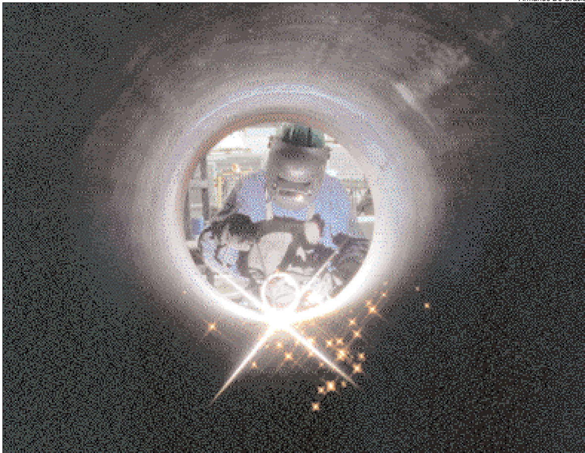
La luz al final del túnel: un trabajador del Canal construye una pieza en la División de Astilleros.
