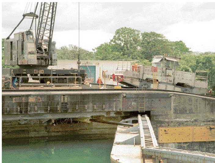
Conversión hidráulica de las compuertas Foto: Armando De Gracia La primera fase del proyecto culminó en el año fiscal 2002 e incluyó 80 compuertas operativas y dos laboratorios de capacitación en sistemas hidráulicos.
