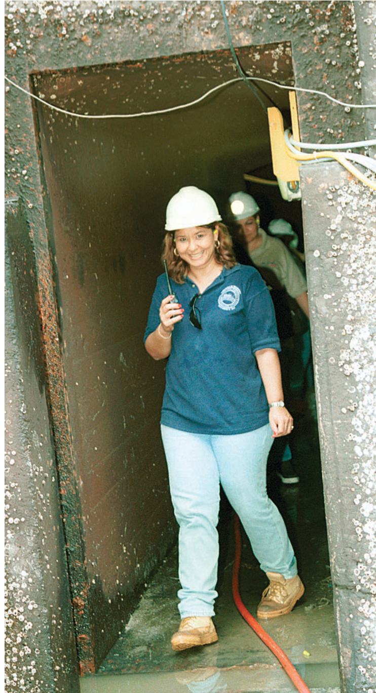
Una mujer en las entrañas del Canal Sixta Díaz de Rodríguez, sale de una alcantarilla durante el reacondicionamiento de las compuertas de las Esclusas de Miraflores.
