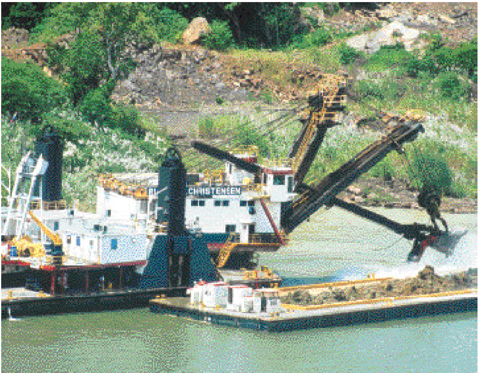
Operación eficiente En la foto superior, el agua es vertida de la Represa Madden que, junto a la Represa de Gatún, controla las aguas del Río Chagres para mantener el nivel del Lago Gatún. A la izquierda, la draga de cucharón “Rialto M. Christensen” es usada, entre otros proyectos, en los trabajos de mantenimiento del cauce del Canal.
