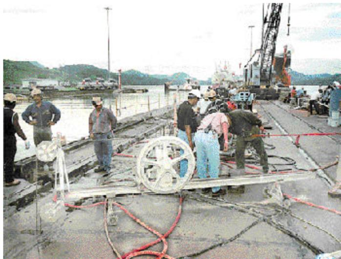
del área para detectar situaciones inseguras. Se hace una demarcación de lo que se va a remover, después de lo cual se perfora y se corta con tecnología de taladros y cable de diamante. En la fecha programada para el cierre de vía, se extraen los bloques y se reemplazan.
