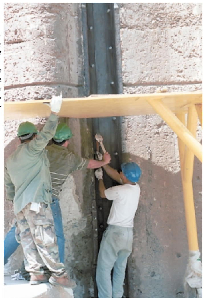
Remueven pernos A la derecha, trabajadores remueven los pernos del plato para poder reemplazarlo.
