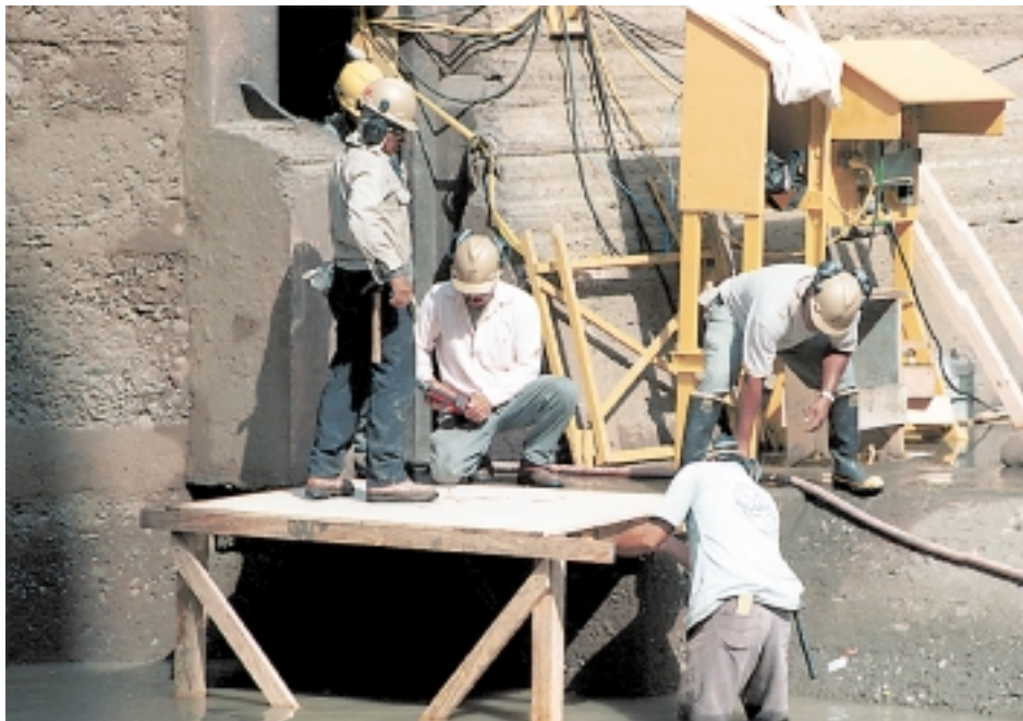
Construyen plataforma A la izquierda, trabajadores arman rápidamente una plataforma en la entrada de la alcantarilla para facilitar el acceso del personal y equipo.
