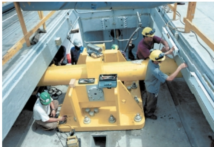
Instalan brazos hidráulicos
