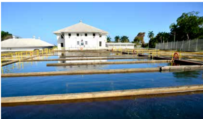
Planta potabilizadora de Miraflores.
