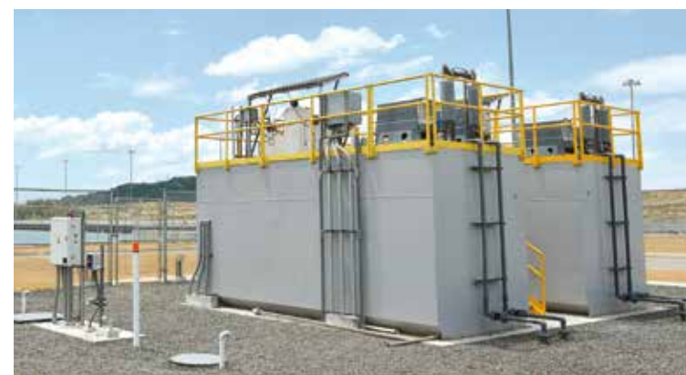
Planta de tratamiento de aguas residuales.
