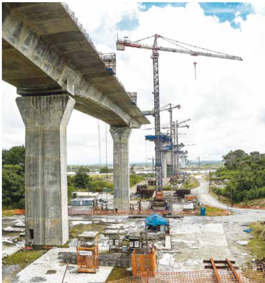
Las obras registran más del 50% de avance.
