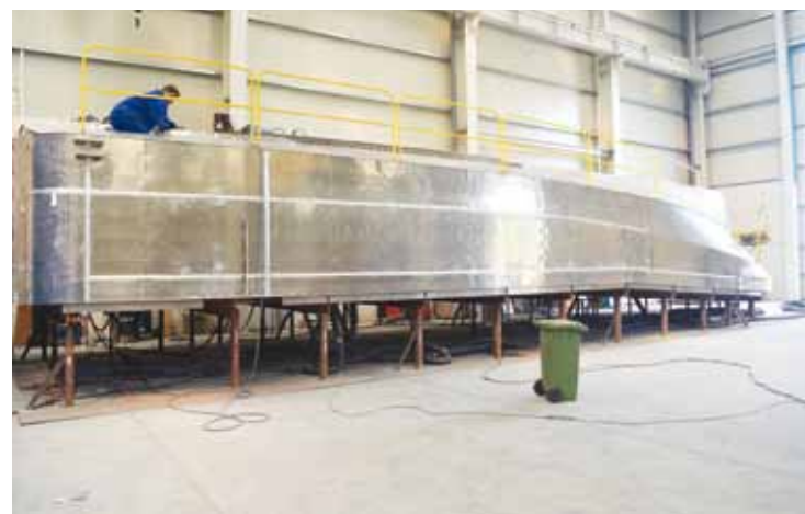
Lancha en proceso de construcción.
