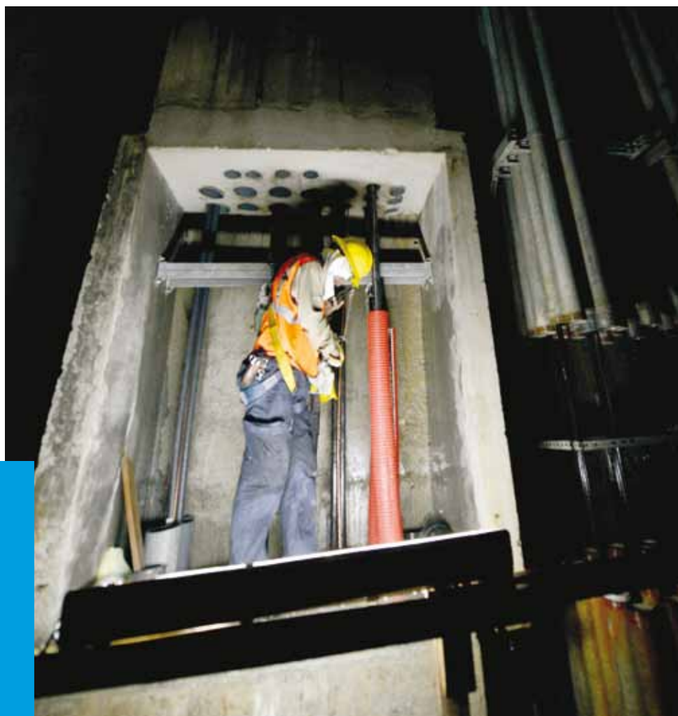
Un colaborador vigila el recorrido del cable en una de las cajas de paso en la primera bajada vertical, lado oeste.
