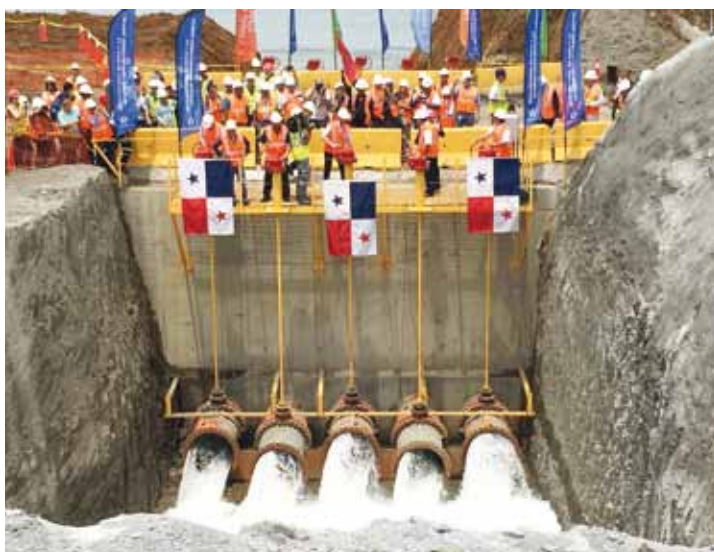
Válvulas que llenan con agua del lago Gatún las esclusas de Agua Clara.
