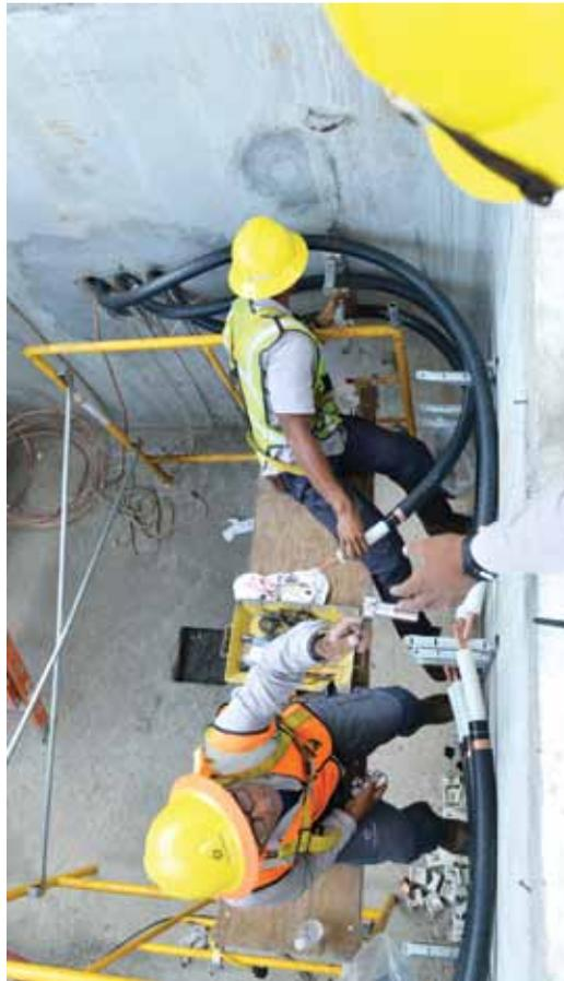
El equipo de Alto Voltaje se encarga de realizar empalmes y terminaciones en la línea de transmisión 44KV en el Tercer Juego de Esclusas, sector Atlántico.
