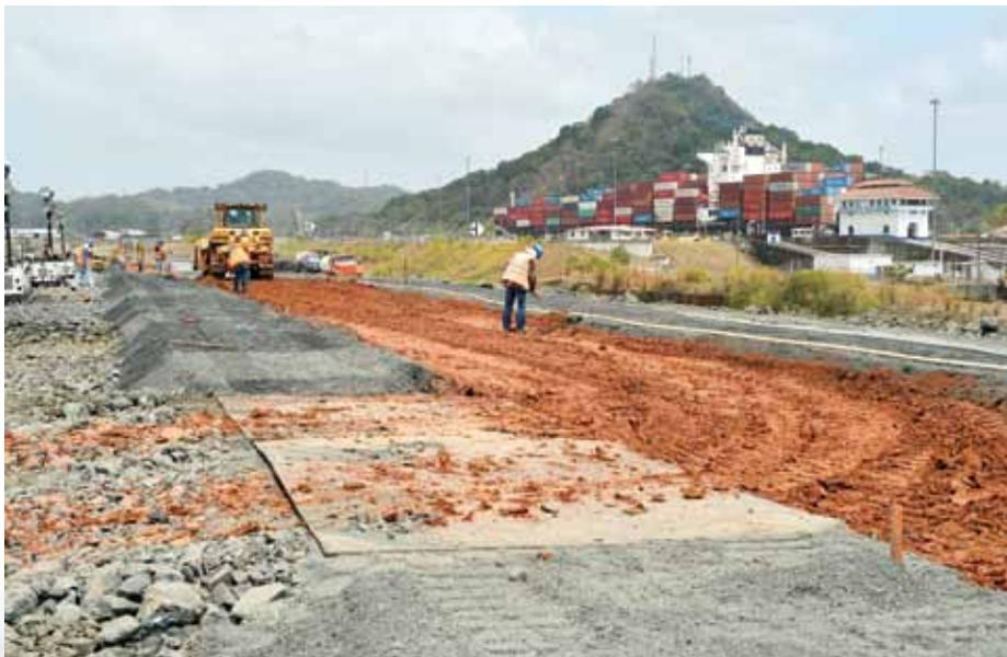
Los trabajos en este sector incluyeron la inyección de una cortina de lechada de cemento en la fundación de la presa, la colocación de una serie de diversos materiales, entre ellos arcilla y material pétreo procesado para que actúen como filtros y para minimizar una potencial filtración por debajo de la presa. La Autoridad del Canal de Panamá da cumplimiento de los requisitos establecidos para la construcción de esta importante estructura.
