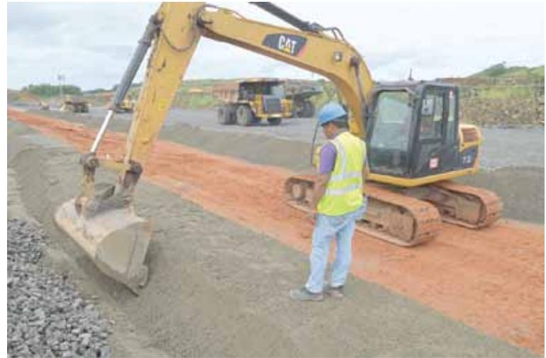
Colocación de filtros y núcleos de arcilla en una de las represas.
