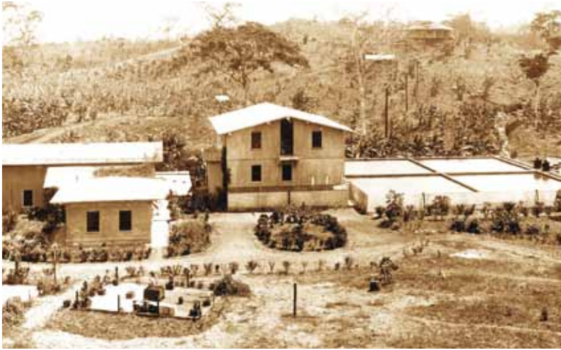
Foto de la Antigua planta de Agua Clara
