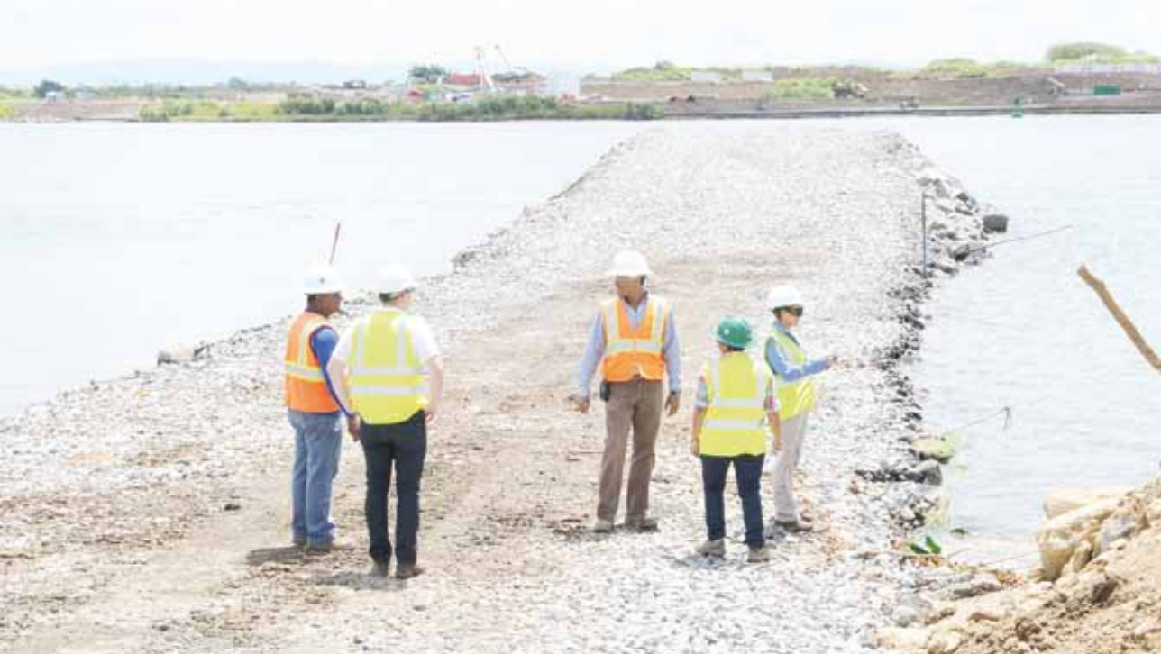
Los especialistas del Programa de Ampliación del Canal llevan a cabo inspecciones socioambientales en los sitios donde se construye el nuevo puente del Atlántico. El recorrido se hace en conjunto con representantes del contratista de la obra (arriba y foto derecha abajo)
