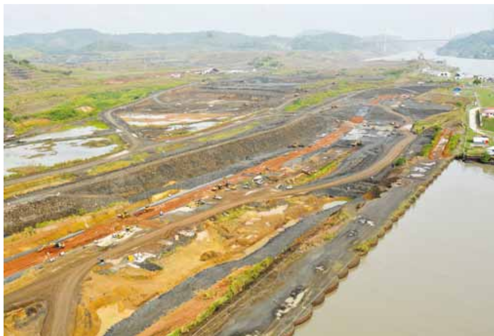
Proyecto de la Excavación del Cauce de Acceso Pacífico Fase 4.
