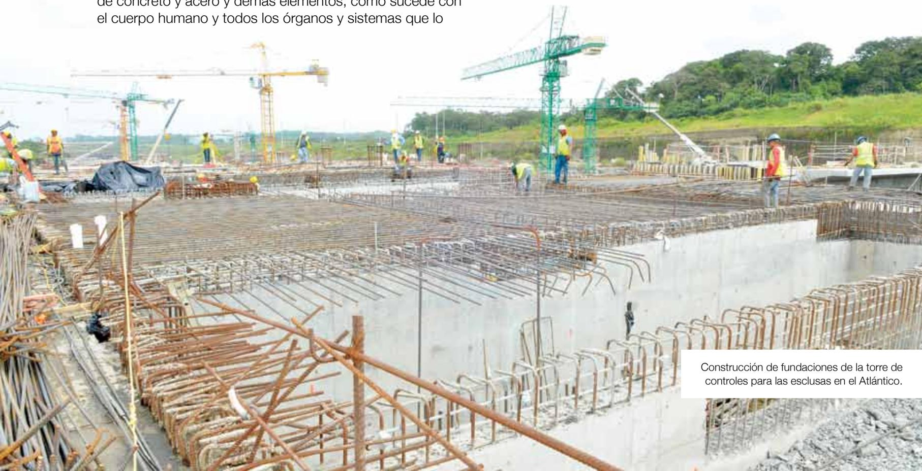
Construcción de fundaciones de la torre de controles para las esclusas en el Atlántico.
