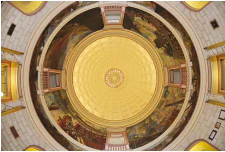
Cúpula del edificio de administración del Canal.
