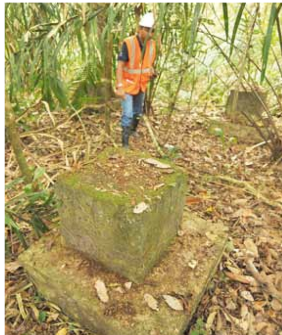
Fundaciones de edificios del antiguo poblado Las Cascadas.
