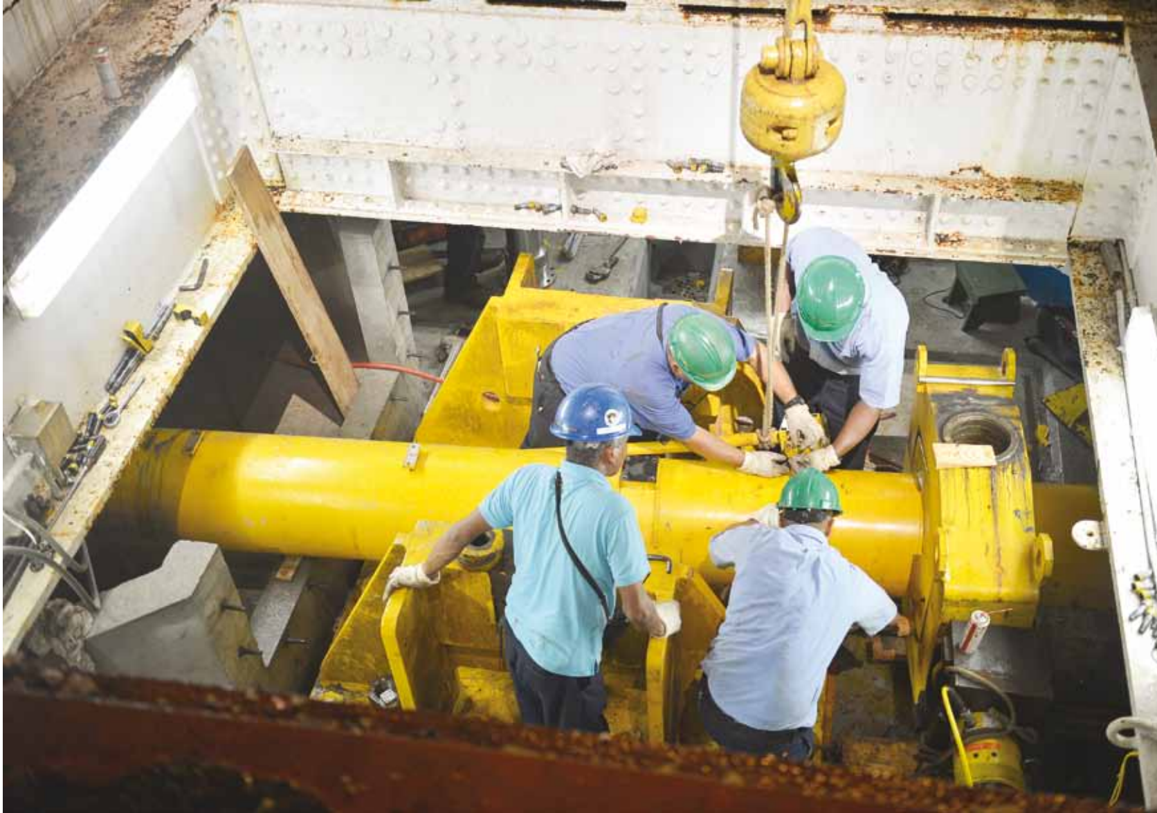
Abajo, en el nicho, los trabajadores sacan los 4 pines que fijan el cilindro al gimbal.
