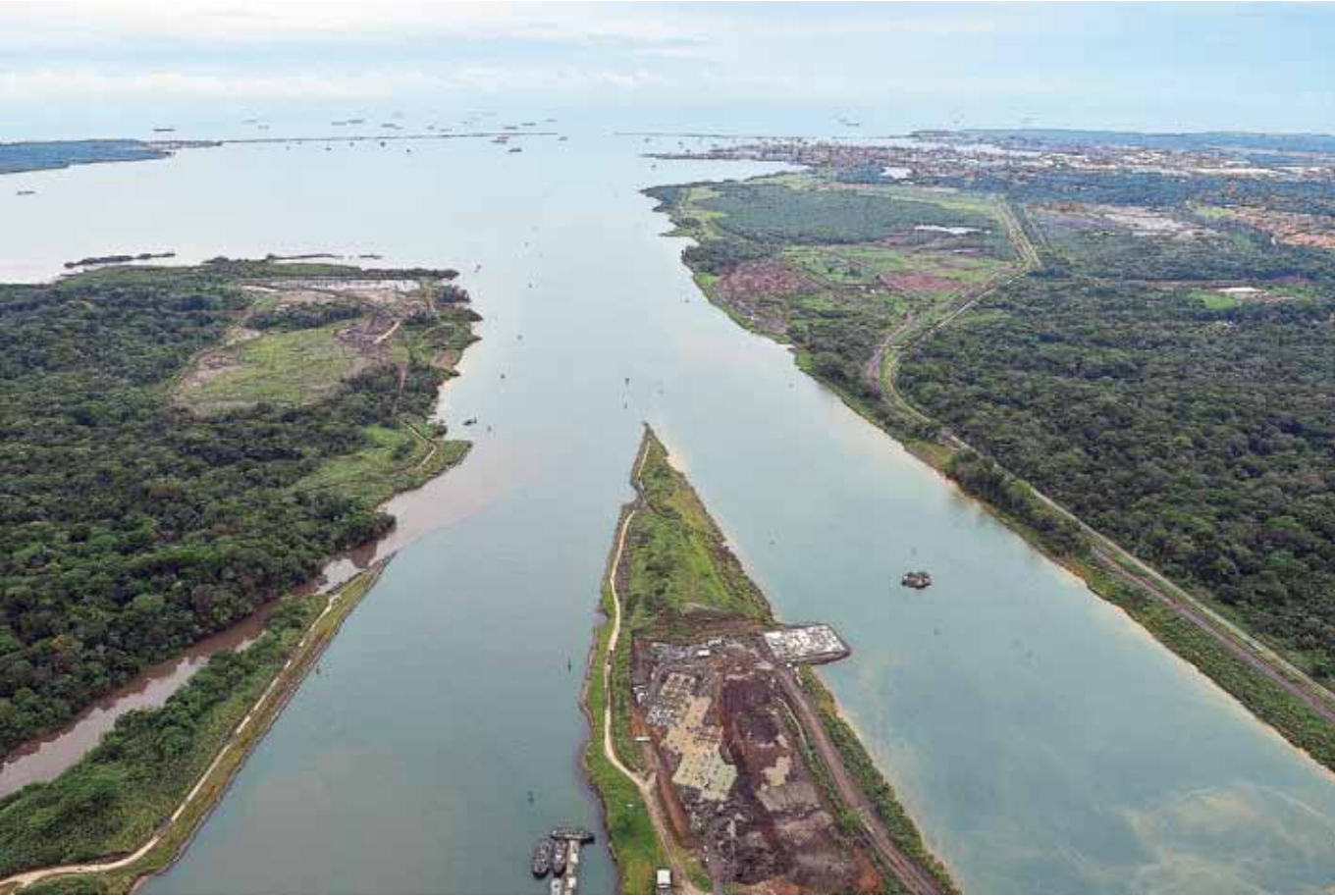
El área de recepción de las compuertas en la península de Davis en la entrada del Canal en el Atlántico. Al fondo, el mar Caribe y la ciudad de Colón.
