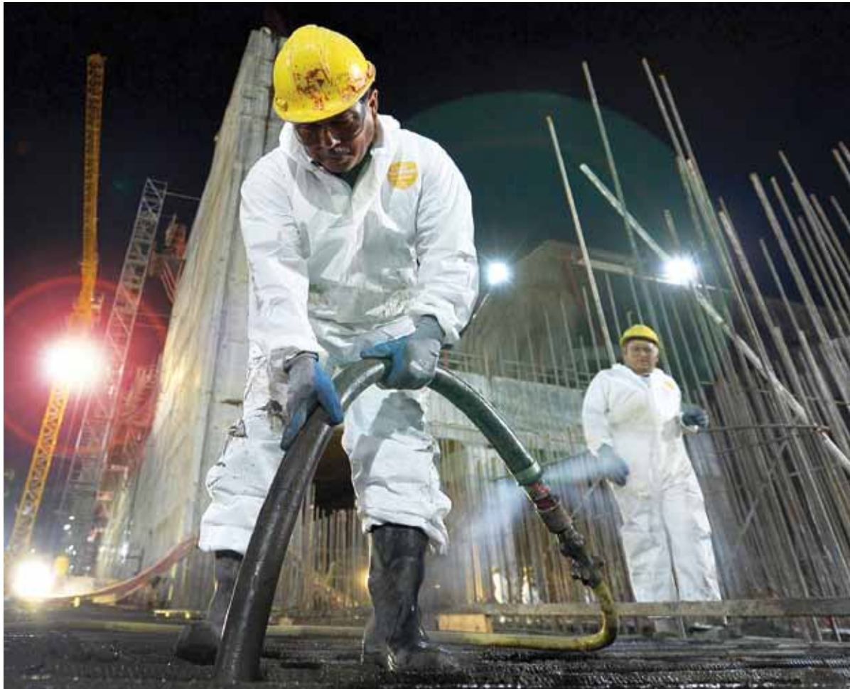
Vaciado de concreto en el proyecto del Tercer Juego de Esclusas.
