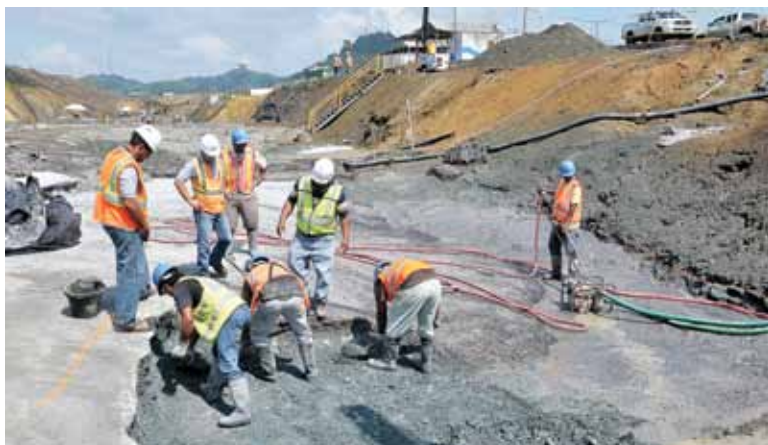
Cuarta fase de excavación seca del Cauce de Acceso del Pacífico.
