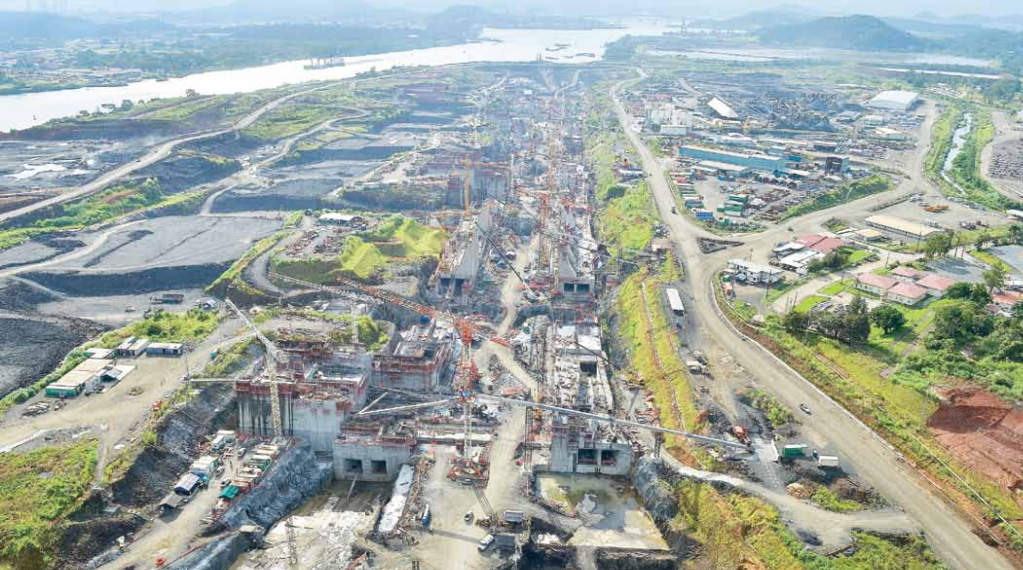
Construcción del Tercer Juego de Esclusas en el lado Pacífico del Canal.
