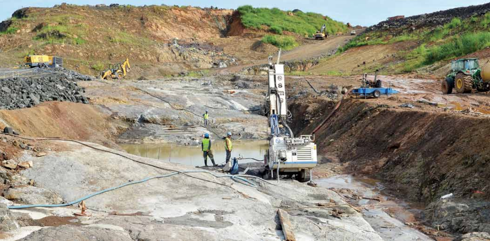
La colocación de una cortina de inyección de lechada de cemento elimina el riesgo de filtraciones de agua en las fundaciones de las presas.
