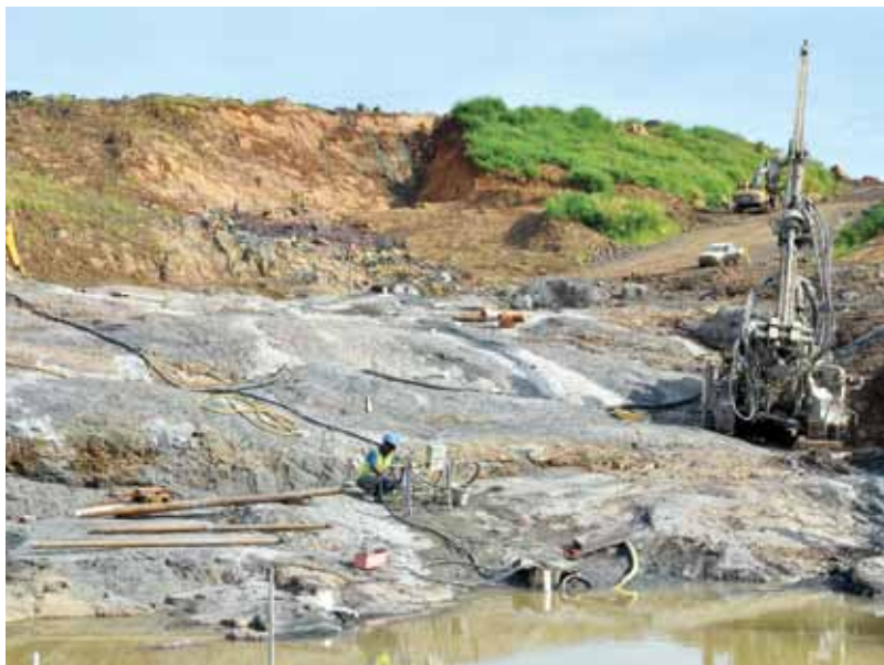
Las nuevas presas tendrán un núcleo impermeable de arcilla, filtros y escollera de roca.
