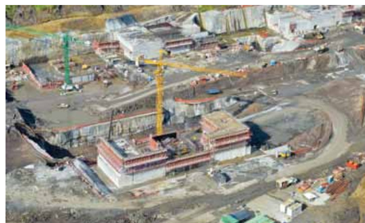
Construcción de los nichos de las compuertas de las nuevas esclusas.
