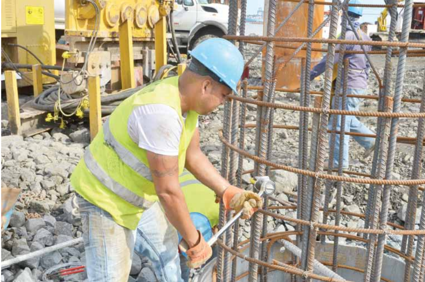
Trabajadores del subcontratista aseguran dos secciones de una de las armaduras de acero de los pilotes del muelle para las compuertas en el Pacífico.
