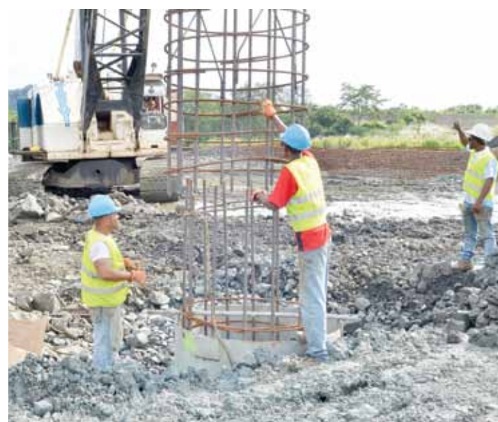
Ayudados por una grúa hidráulica, los trabajadores alinean dos secciones de la armadura de acero de uno de los pilotes de concreto.
