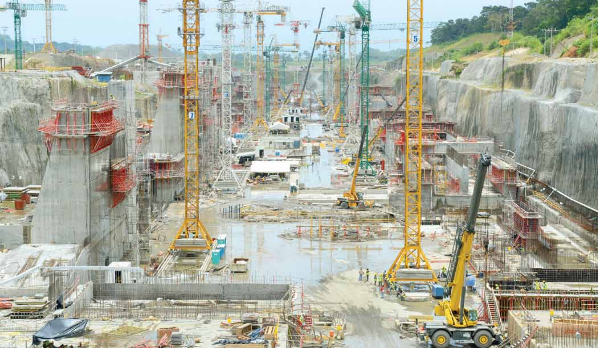
En la excavación del Tercer Juego de Esclusas, 27 grúas torre giran con suavidad de lado a lado 24 horas al día como gigantescas manecillas de reloj.
