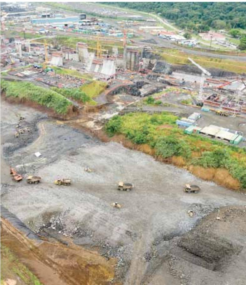
Equipo pesado trabaja en el relleno de la excavación contigua a la construcción de las esclusas.
