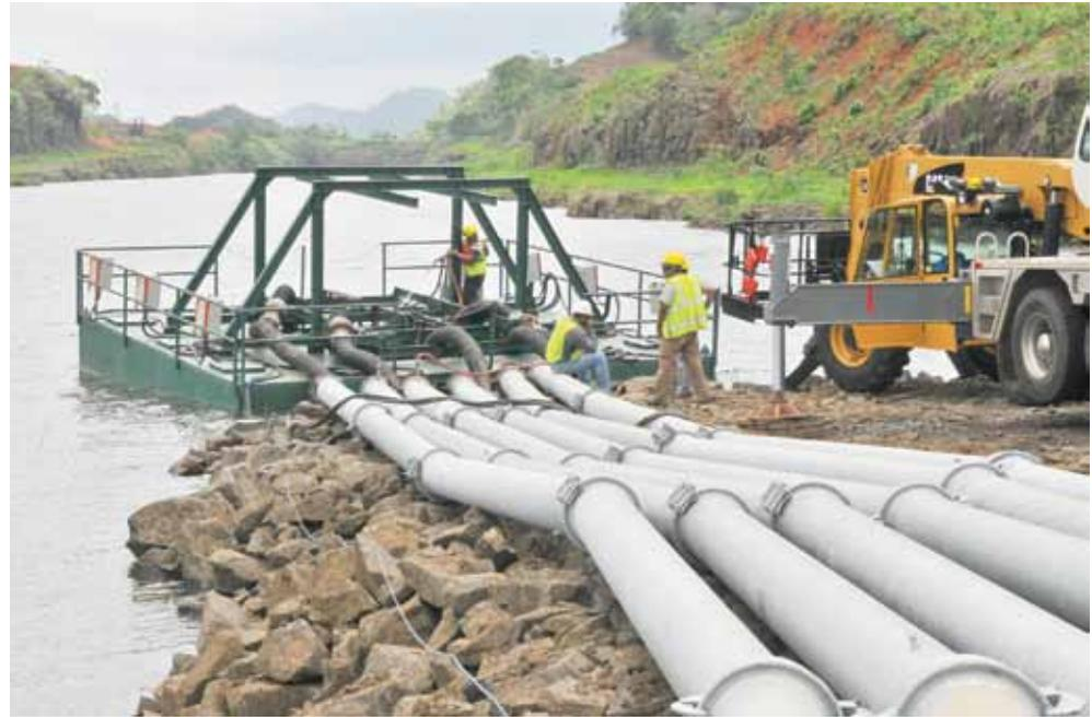
Instalación de bomba para el desagüe de la excavación sur de 1939.
