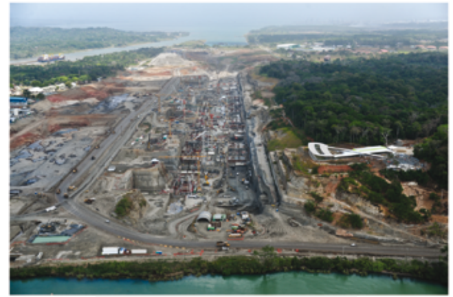
Vista general obra Atlántico - Marzo 2012
