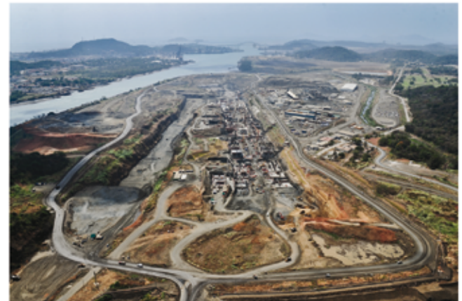
Vista general obra Pacífico - Marzo 2012
