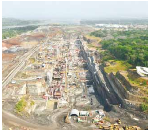
Construcción de las nuevas esclusas en el Atlántico.
