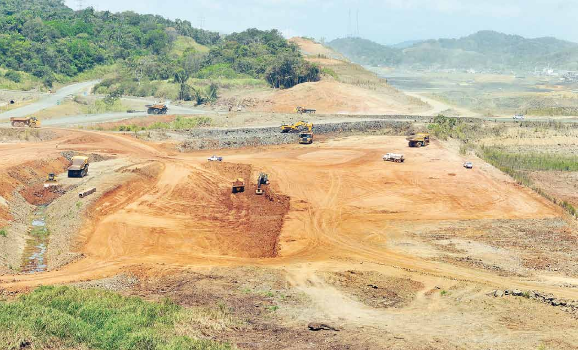
Vista de los trabajos de ampliación en el Pacífico.
