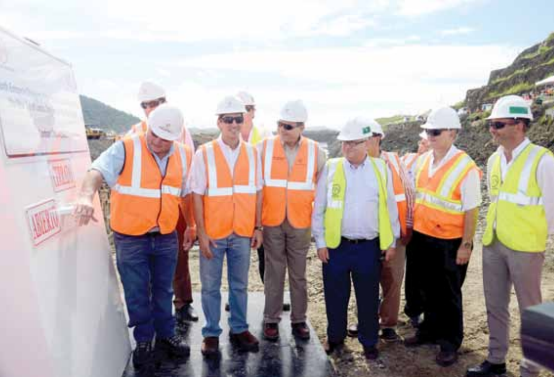
El presidente Ricardo Martinelli activa las válvulas para el inicio del llenado del nuevo cauce del Canal de Panamá.
