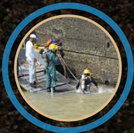
**1** Dentro del mantenimiento que se le da periódicamente a las esclusas, los buzos inspeccionan los sellos sumergidos de compuertas y válvulas, y de encontrar una necesidad real se planifica el vaciado de las cámaras.
