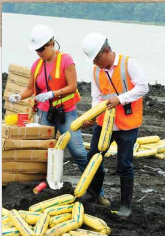
Irene Villalaz y Alvaro Díaz preparan los “bollos” o cartuchos de explosivos para la voladura.
