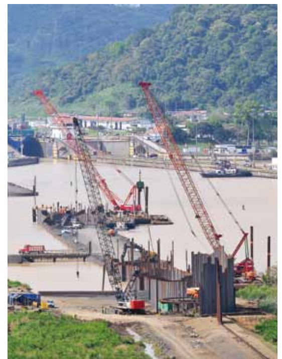
La construcción en seco de la presa comenzará una vez se instale el sistema de ataguaje celular de 1.8 km. de longitud que aislará el lago Miraflores de la excavación.
