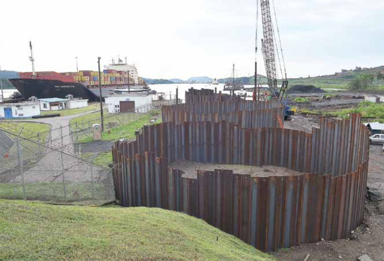
La construcción en seco de la presa comenzará una vez se instale el sistema de ataguaje celular de 1.8 km. de longitud que aislará el lago Miraflores de la excavación.
