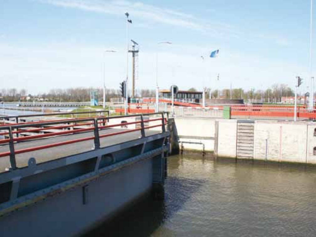
Compuertas deslizantes en la esclusa Prins Alexandersluis ( complejo de esclusas naranja) en Amsterdam, Holanda.
