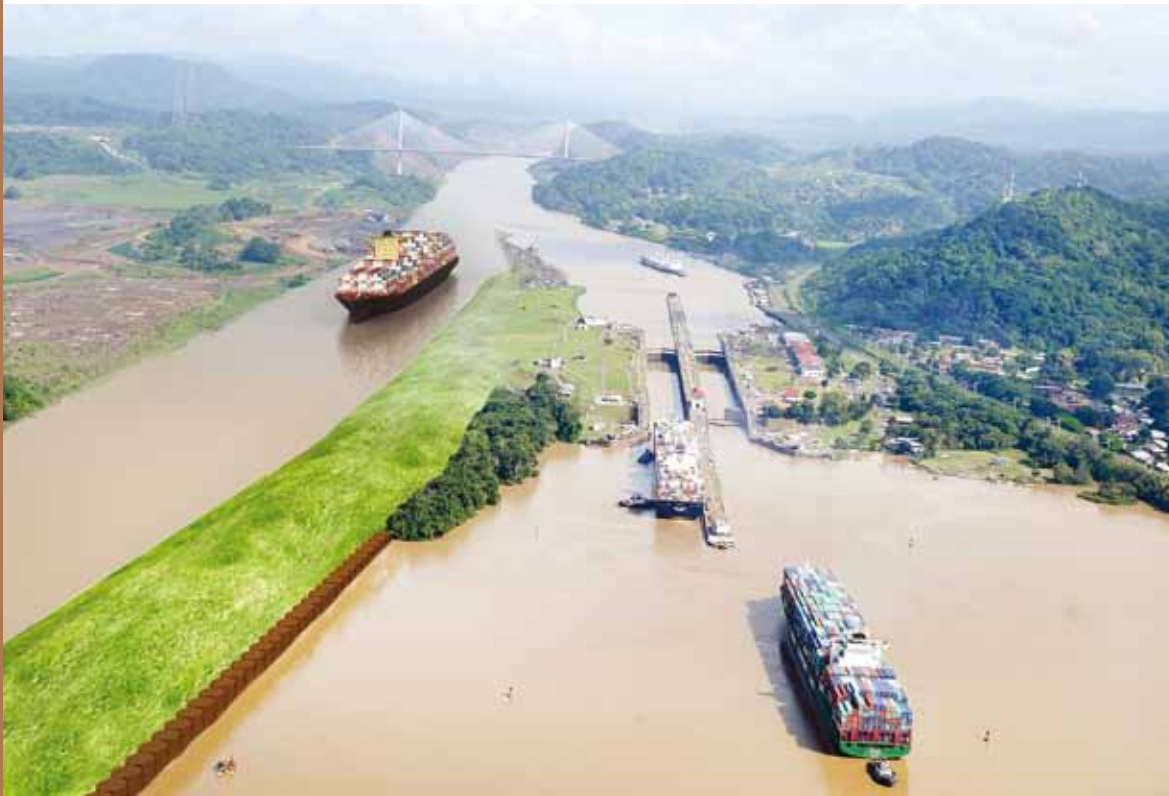
Imagen de la presa Borinquen 1E.
