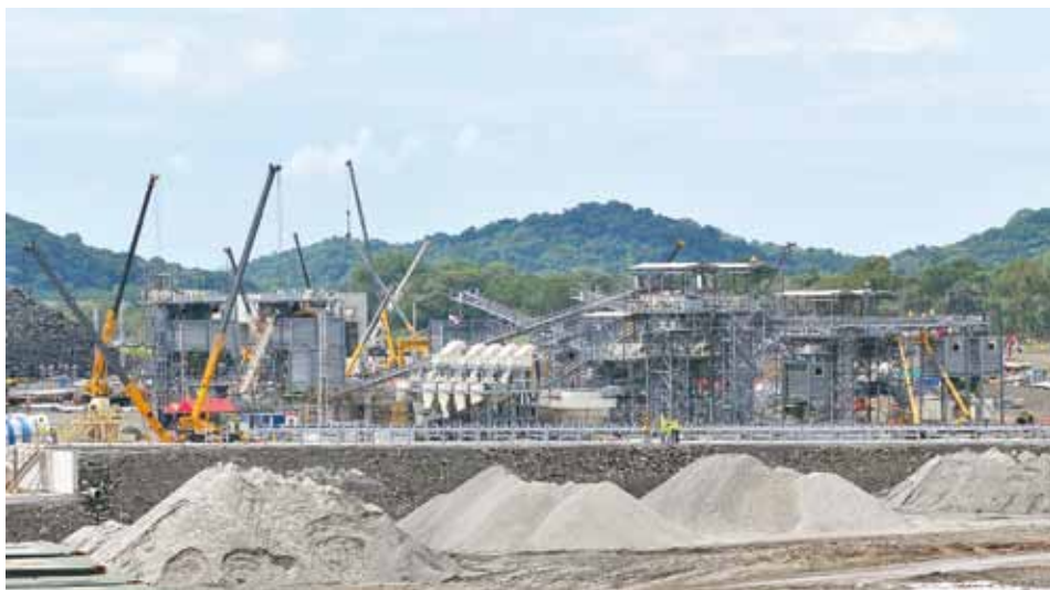
Planta industrial para apoyar la construcción de las esclusas del Pacífico.
