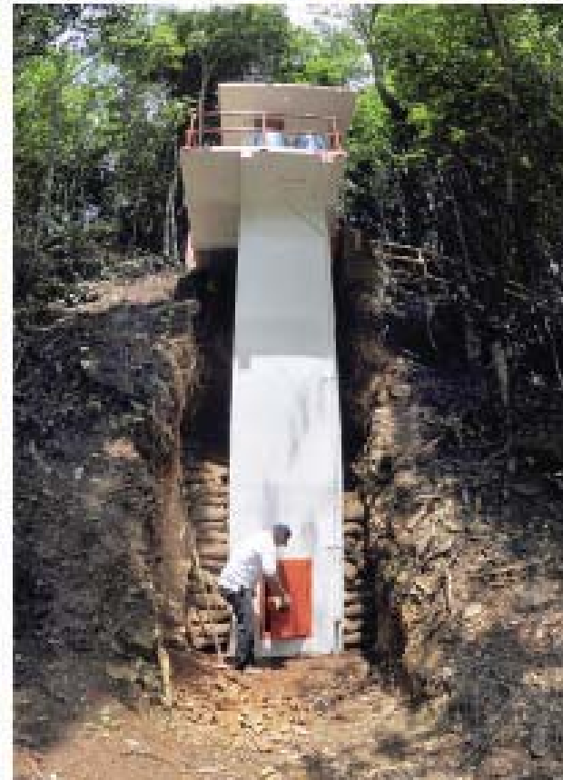
En Guarumal se construyó por primera vez en más de 60 años un poste amarriguado de 14 pies para medir el caudal del río Indio.
