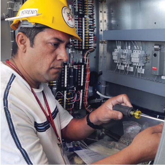
Jaime Moreno, electricista de la Unidad de Mantenimiento de Bajo Voltaje.
