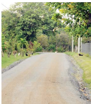
Rehabilitación de calle
