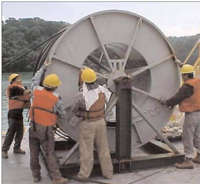
Antes de iniciar la instalación, se dan charlas de seguridad para garantizar que el personal conoce los procedimientos y se eviten accidentes. Los trabajadores utilizan chaleco salvavidas, casco, guantes, botas de seguridad y están en comunicación por radio o celular con personal en tierra.
