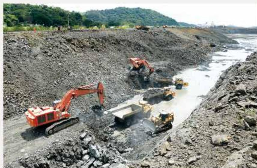
Extraer la dura piedra para dar paso al agua del canal primero fue tarea de palas de vapor y vagones, un siglo más tarde, potente palas electromecánicas se combinaron con camiones para las excavaciones del Tercer Juego de Esclusas.
