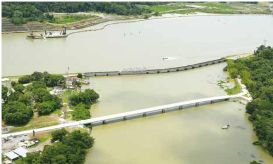
Esta obra tiene una longitud de 278 metros, con ocho claros de 34.75 metros cada uno. Además, dos carriles de tráfico vehicular (uno en cada sentido) de 3.65 metros cada uno y una acera peatonal de un metro de ancho. Incluye los accesos de pavimento rígido de concreto en ambos extremos a conectarse con las vías existentes.
